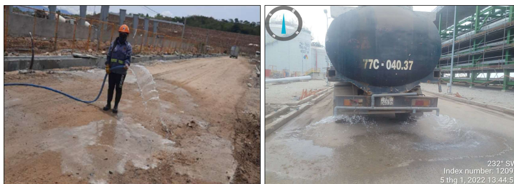
Hình 2.4: Hoạt động tưới đường tại khu vực thi công
