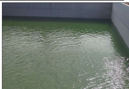
Hình 1.3: Bể chứa nước thử thủy lực sau khi được lọc qua bộ lọc
