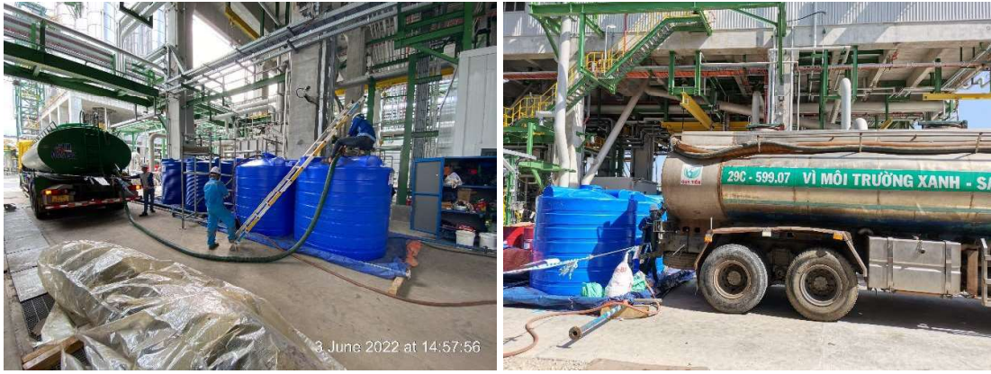
Hình 1.11: Lưu chứa và thu gom nước thải vệ sinh bằng hóa chất – Gói thầu BC
