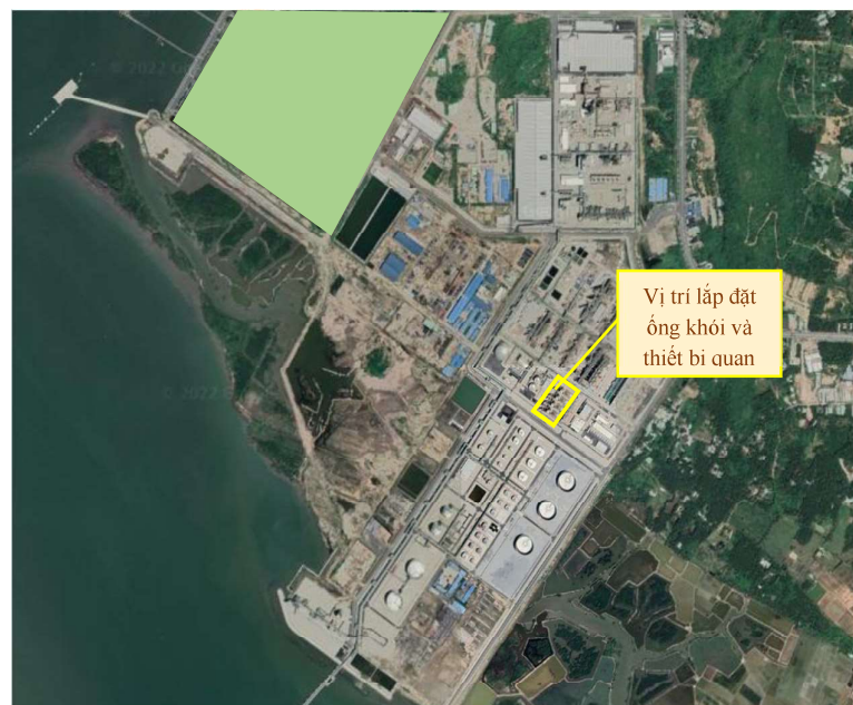
Hình 2.8: Vị trí lắp đặt hệ thống quan trắc khí thải tự động
