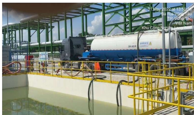
Hình 1.8: Xe bồn thu gom nước thải từ quá trình thụ động hóa hệ thống tháp làm mát
