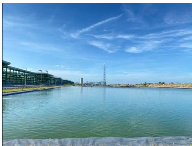
Hình 1.9: Hồ lưu chứa tạm thời nước làm mát thải
